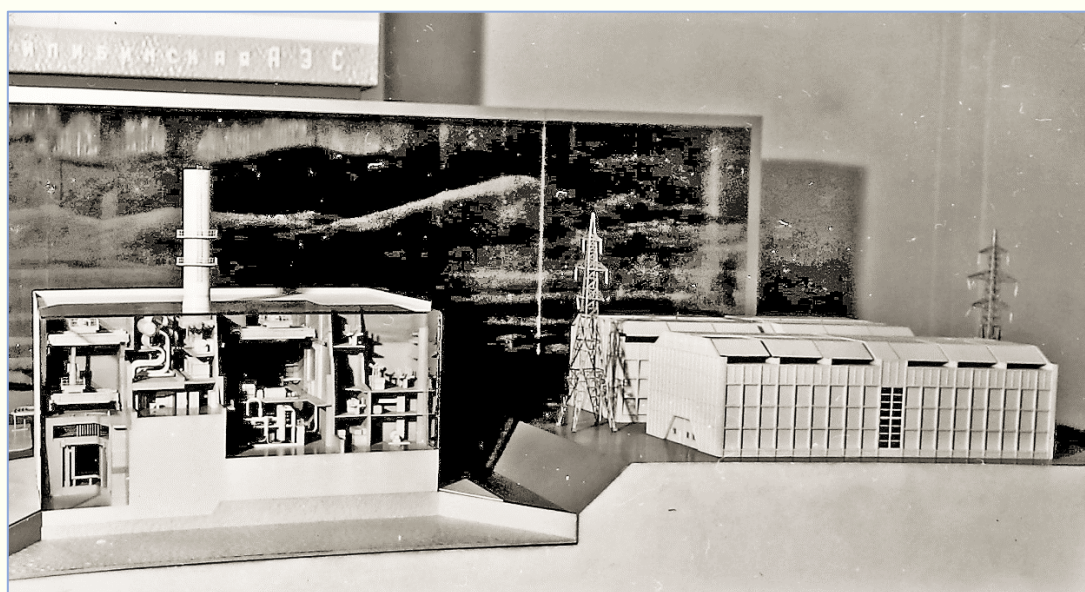
Макет Билибинской АЭС. Схема получения пара, электроэнергии и горячей воды.
